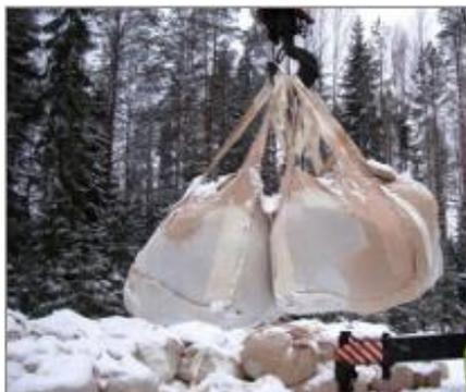
**Контейнеры текстильные КТ** предназначены для балластировки трубопроводов на болотах. Заполняются при помощи передвижного бункерного устройства минеральным грунтом на трассе или в карьере до монтажа на трубопроводе. КТ изготавливаются из высокопрочных, долговечных в грунтовых условиях технических тканей.
